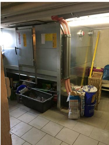
Die alte Ölheizung wurde durch eine **Pelletheizung** ausgetauscht. Laut Energieausweis beträgt der jährliche Ertrag aus „Wärme aus Kesseln – Biomasse fest“ insgesamt 15.114 kWh.
