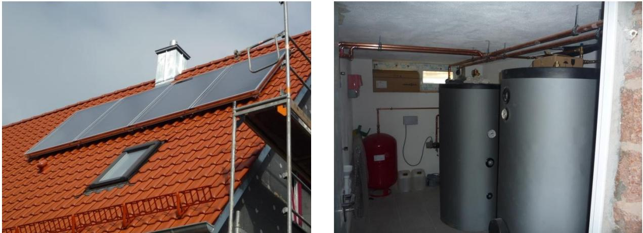
Abbildung 3-1: Solarthermie-Dachanlage und zugehöriger Pufferspeicher (eta, 2019)
