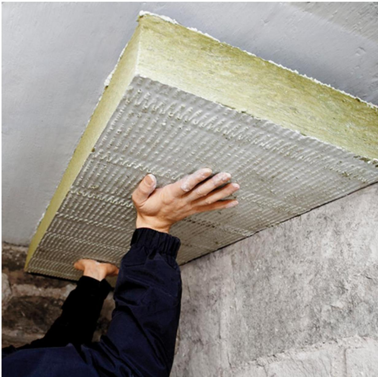
*Abbildung 7-1: Anbringen der Dämmung an eine Kellerdecke von unten (Dämmen-und-Sanieren, 2019)*
